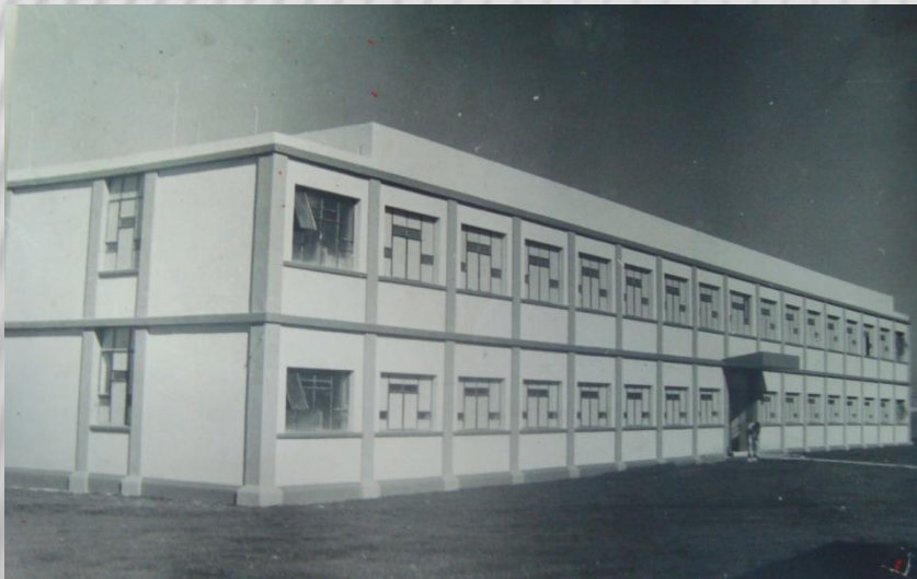
Reutilización de inmuebles para nuevas escuelas
