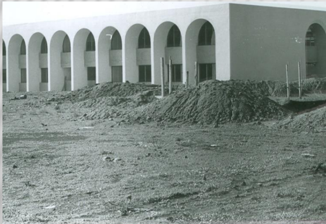
Edificios de CU en construcción, diseño CAPFCE Edificación TASA. S.A.
