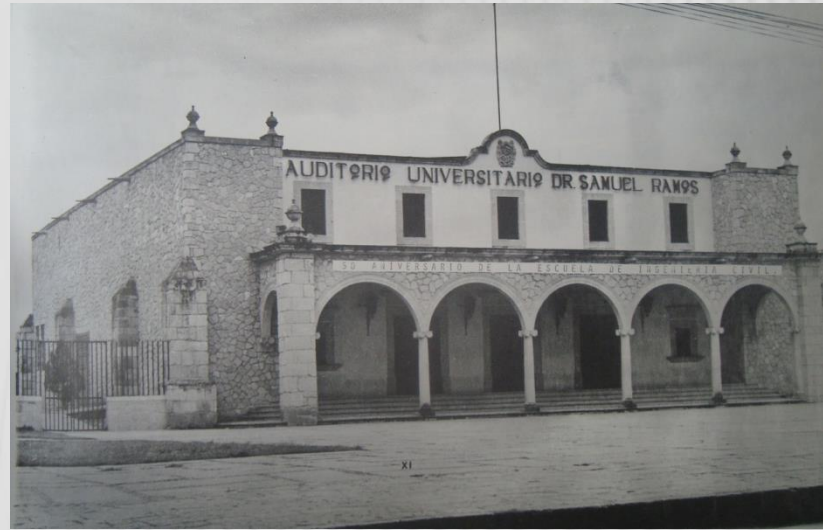
Construcción del auditorio Samuel Ramos
